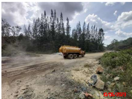
รูปที่ 8 การฉีดพรมน้ำบริเวณพื้นที่โครงการ
